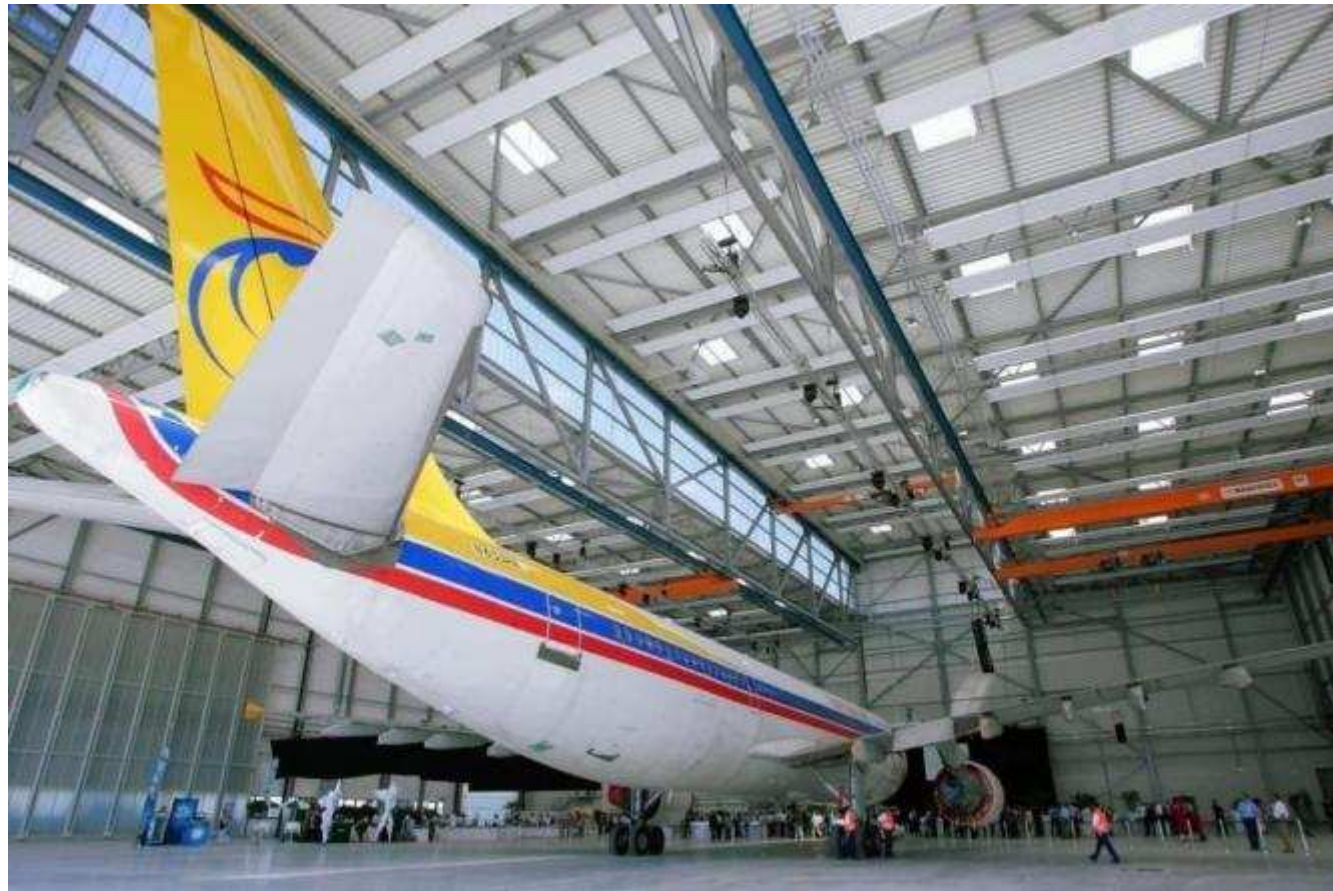
Paneles de techo radiante de máximo rendimiento
