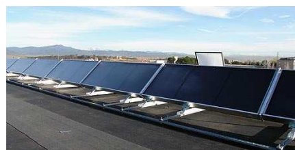
Instalación en nave industrial en Gerona
